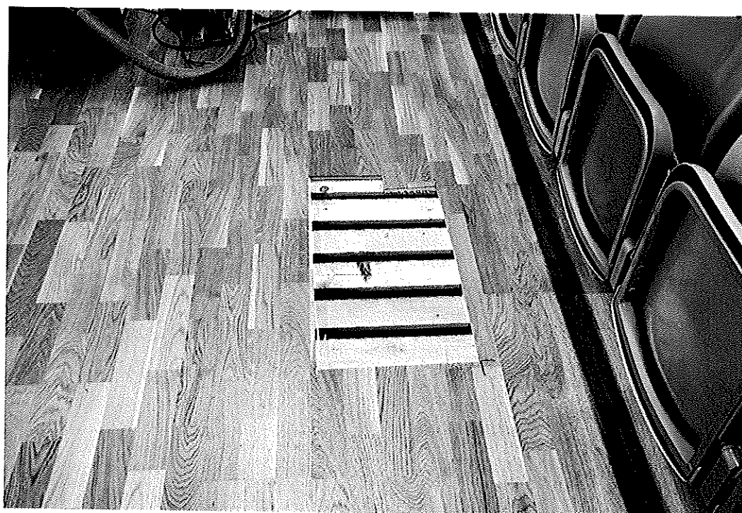
Fot. 2 Demontaż fragmentu nawierzchni
