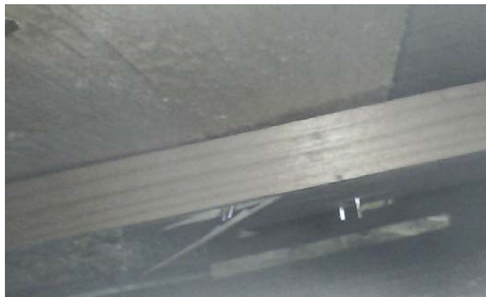
Zdeformowana deska legara górnego.
