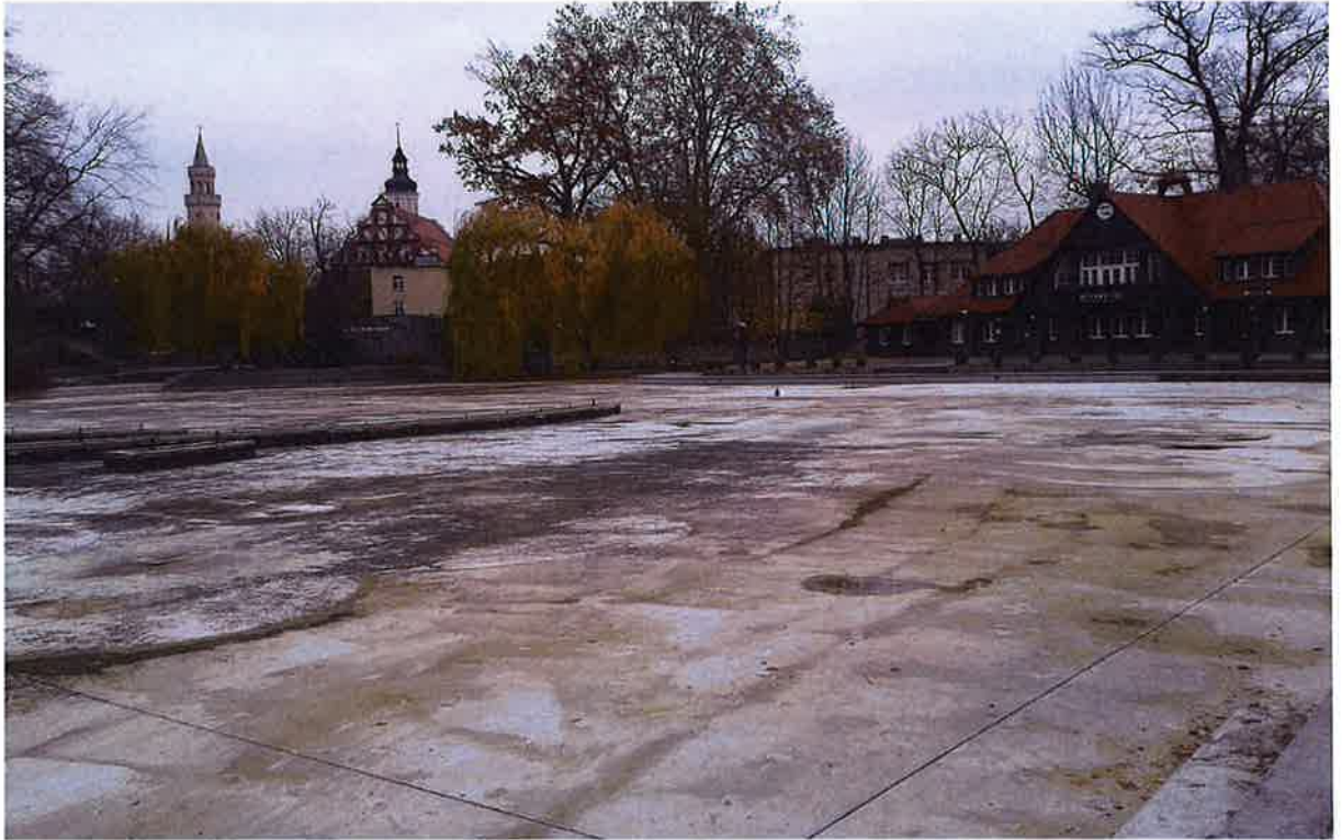
Widok strefy przeznaczonej pod montaż lodowiska zewnętrznego oraz zaplecza sprzętu i obsługi.
