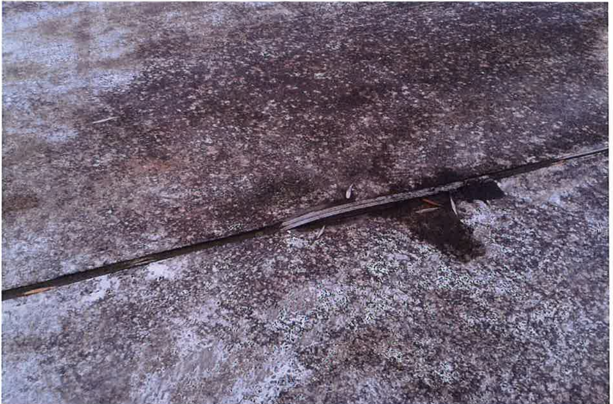
Miejscowa deformacja taśmy dylatacyjnej w płycie dennej.
