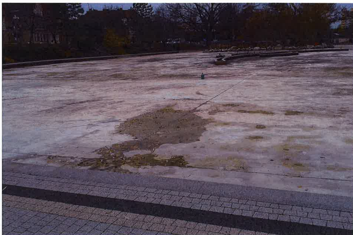
Widok strefy przeznaczonej pod montaż lodowiska zewnętrznego.
